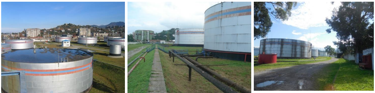
ნახაზი 3.3.4.1. ხალოდნაია სლობოდას რეზერვუარები
