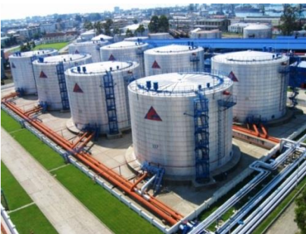
ნახაზი 3.3.1.3. №№224 ÷238 რეზერვუარების პარკი ძირითად ტერიტორიაზე
