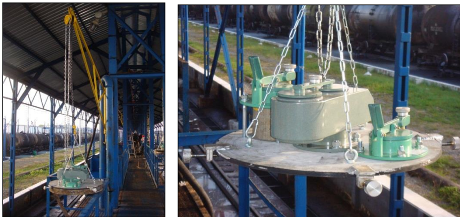
სურათი 3.4.1.1. ჰერმეტიზაციის სარქველები № 5 სარკინიგზო ესტაკადაზე
