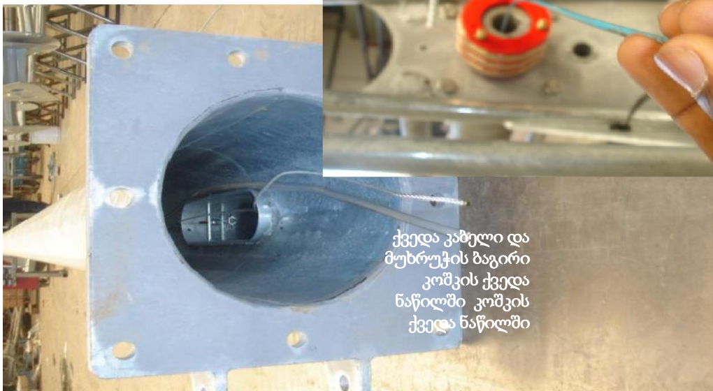
ქვედა კაბელის დასამონტაჟებელი ჭოკი ტარდება კოლექტორულ რგოლში კომპის თავიდან მის ბოლომდე
