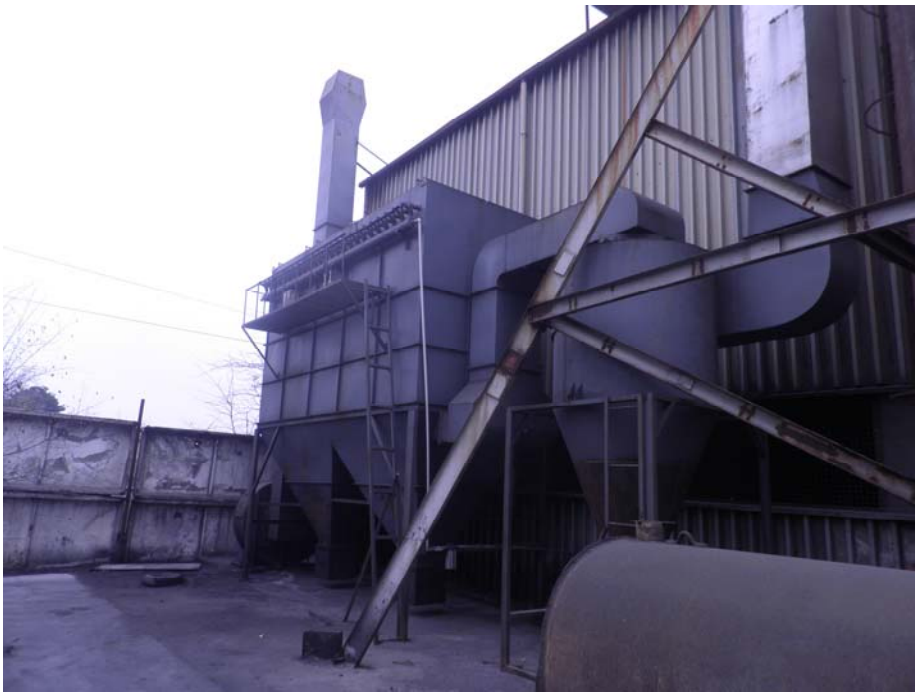
სურათი 3. მრუნავი ღუმელის აირმტვერნარევის მამწმენდი სისტემა.
