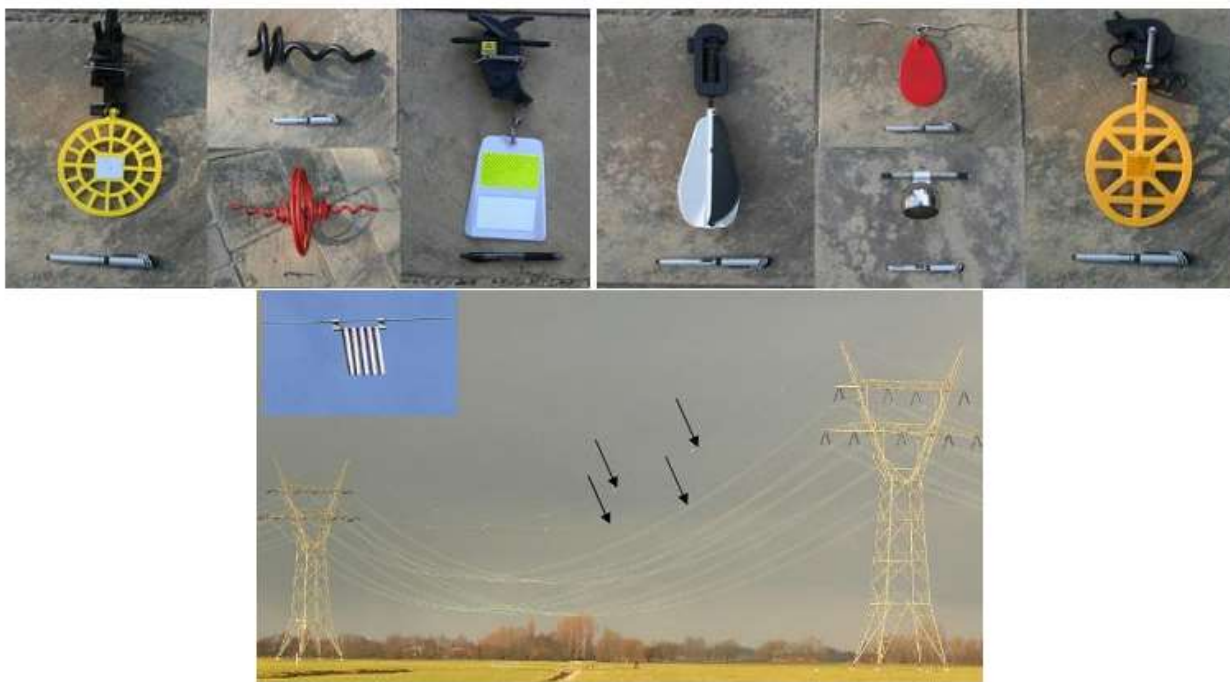
სურ. 6.9.4.1. ეგზ-ების სადენებზე გამოყენებული მარკირების მაგალითები
