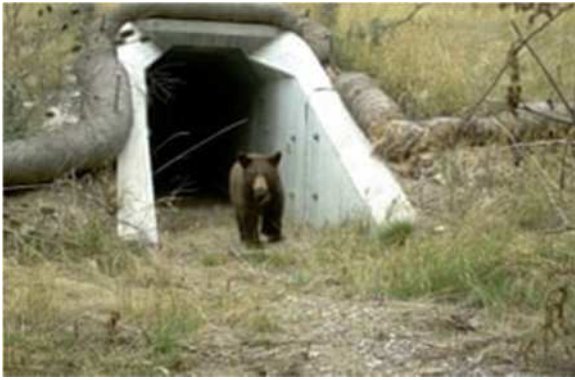
ნახაზი 54. ცხოველების გადაადგილება გზის ინფრასტრუქტურის ქვეშ მოწყობილი გასასვლელებით (ფოტოების წყარო: ინტერნატი)
