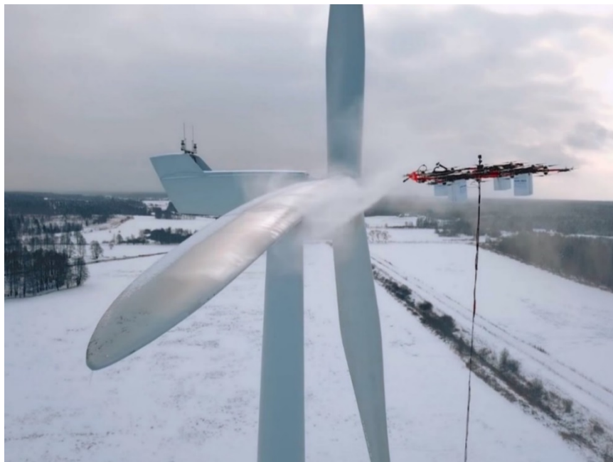
სურათი 6-10 დრონის გამოყენება ქარის ტურბინის გასაწმენდად
